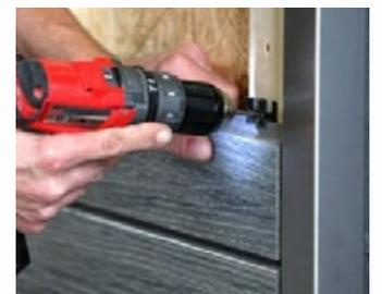
Fassadenprofile werden mit einer Nut- und Spundverbindung formschlüssig auf einer Holzunterkonstruktion angebracht.
