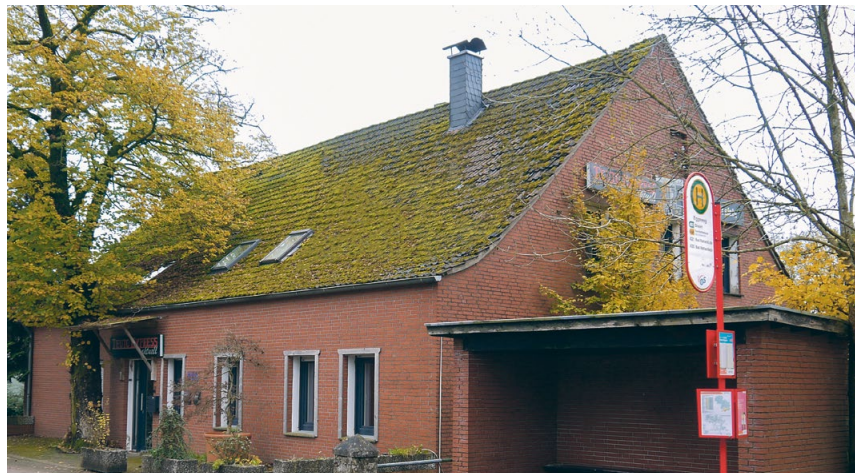
Das Gebäude heute nach der letzten Renovierung – mit den neuen Fenstern.
