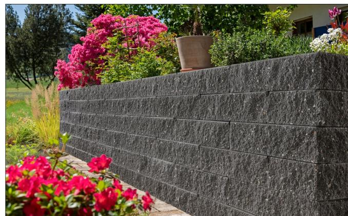
txn. Das Mauer- und Böschungssystem Muro Renature besteht zu 30 Prozent aus einer Recyclingkörnung. Das ist gut für die Umwelt und wird zum nachhaltigen Hingucker im Außenbereich.
